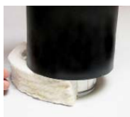
Isolera noggrant runt kopplingsstycket.
